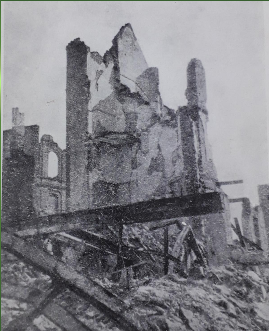
Die Schuttkrippe der Kirche Schönbrunn- Vorpark, Wien XV
